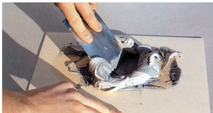
I due componenti dello stucco EPOMAST devono essere miscelati fino ad ottenere un colore omogeneo.
